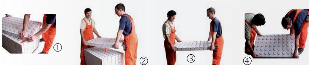
Legen Sie die Kompakt-Platten zuerst an einer Kante, dann komplett auf. Hochkant-Lagerung führt zu Verformungen der Platten und Kantenbeschädigung. Der horizontale Plattentransport im Gebäude ist mit Hubwagen oder anderen Plattentransportwagen möglich.
