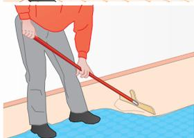
Nach Ablauf von 3 Stunden (bei 20 °C) nach Einbringen der Kompakt-Füllmasse muss die Oberfläche der Kompakt-Fußbodenheizung grundiert werden (Geeignete Grundierungen siehe Kapitel 5.4). Anschließend wird die 2. Schicht Kompakt-Füllmasse aufgebracht.
