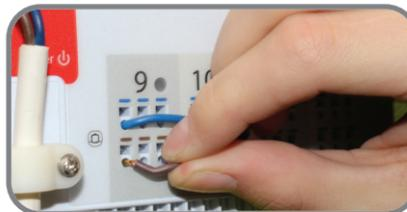
**11** Brechen Sie die Aussparung für die Anschlussleitung der KL04RF heraus.
