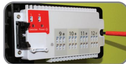
**8** Montieren Sie die Anschlussleitungen der Stellantriebe in die Anschlussklemmen der KL08RF für Stellantriebe. Sie können in jeder Zone bis zu vier Stellantriebe anschließen.
