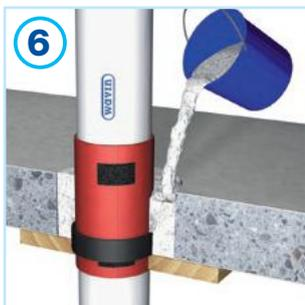
Durchbruch (Wand/Decke) durchgehend mit Beton oder Mörtel verschließen. Bei Leichtbauwänden muss der Ringspalt (s. S. 114, Bild 2, 6a) 25 mm tief mit Gips verschlossen werden.
