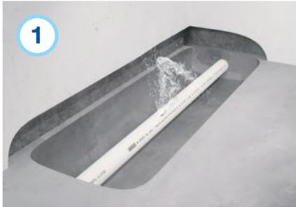
Bereich um die Leckagestelle freilegen, falls z. B. mit Putz oder Beton bedeckt.
