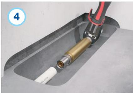
Montierte Verbindung verpressen.
