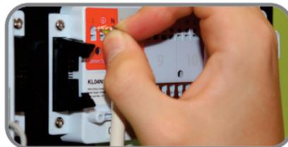
**8** Montieren Sie die weiße Zugentlastung mit den 2 Schrauben, um die Leitung der Spannungsversorgung zu sichern.
