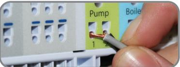
**10** Montieren Sie die Verdrahtungsleitung zum Boiler in die Anschluss terminals Boiler unten rechts an der KL08RF für ein potentialfreies Schalten des Boilers. Sobald eine Zone einen Heizvorgang anfordert, schließt der Boilerschalter und der Boiler wird in Betrieb gesetzt. (POTENTIALFREI) **VOLT FREE**
