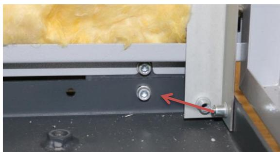
Das Gestell der Pelleteinheit kann nun samt Elektronik vom Kesselkörper getrennt werden.
