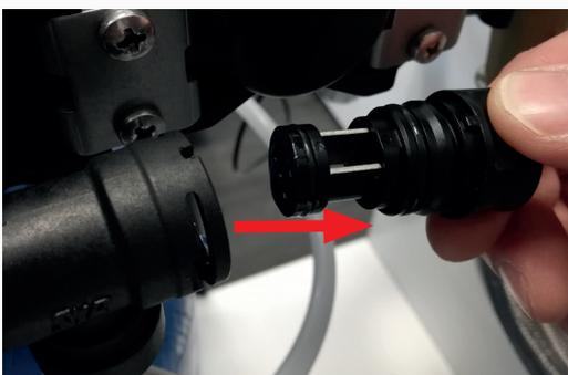
Ziehen Sie die Chlorzelle aus dem Gehäuse heraus.
