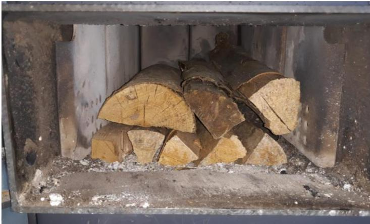
4. Nun kann die Brennkammer nach oben mit größeren Scheithölzern möglichst luftdicht vollgeschichtet werden. Dabei sollten die Größten Scheite nach oben gelegt werden! Der Querschnitt der Scheite muss der Breite des Brennraumes angepasst werden. Um eventuelle Hohlbrände durch „verkanten“ zu vermeiden wird empfohlen, die Breite so zu wählen, dass mind. 3 Scheithölzer nebeneinander passen.
